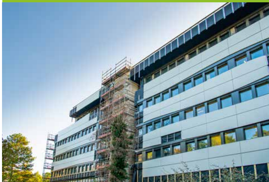
Travaux d'écocémentation - Hôtel du Département, Grenoble
